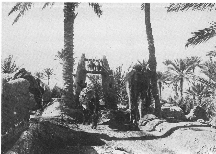
Puits à traction animale dans l'oasis d'Ouargla vers 1930. Montants bâtis en terre (Photo E. Laoust)
